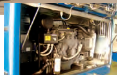
Установка электроагрегата АДС (двигатель DEUTZ + генератор SINCRO) Р-120kW, напряжение 650 В постоянного тока на троллейбусе.
